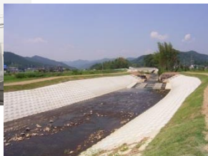
河川改修工事
