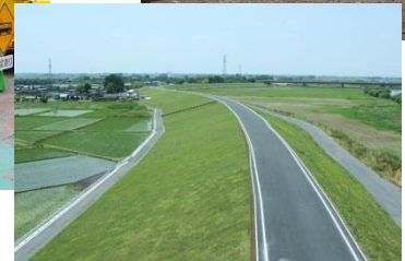
河川改修工事
