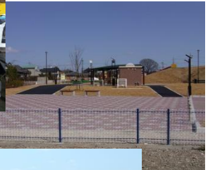
公園新設工事
