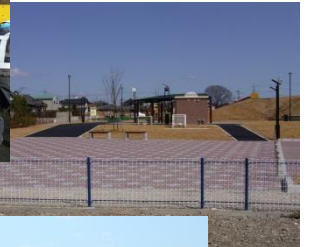
公園新設工事
