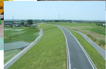
河川改修工事
