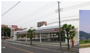
店舗新築工事
