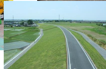
河川改修工事
