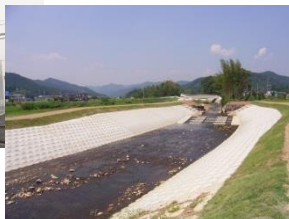
河川改修工事
