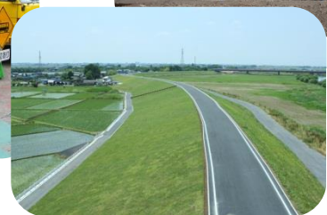
河川改修工事
