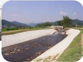
河川改修工事
