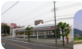
店舗新築工事
