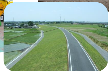
河川改修工事
