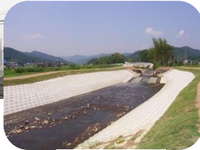
河川改修工事
