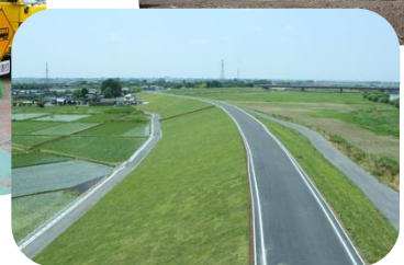
河川改修工事
