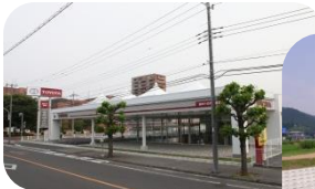
店舗新築工事
