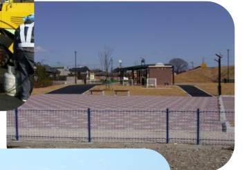
公園新設工事
