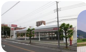
店舗新築工事
