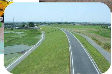
河川改修工事
