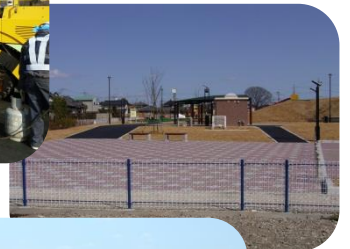
公園新設工事
